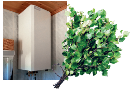
Leinon vanhaan maalaistaloon on asennettu Jäspin VLK 30 lämminvesivaraaja
