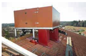
Блок вытяжного дефлектора, размещенный на крыше многоэтажного дома.
